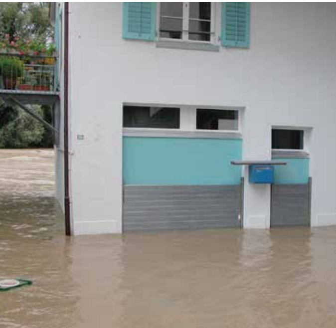
Hochwasser im Schweizer Kanton Aargau, die Reuss tritt über die Ufer. WP WASTO verhindert den Wassereintritt in das Gebäude.
